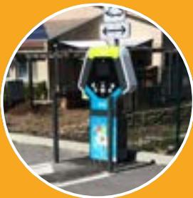
Elles permettent une recharge de 100km du véhicule en moins d'une heure, sur la plupart des véhicules acceptant une recharge accélérée à 22kW.
